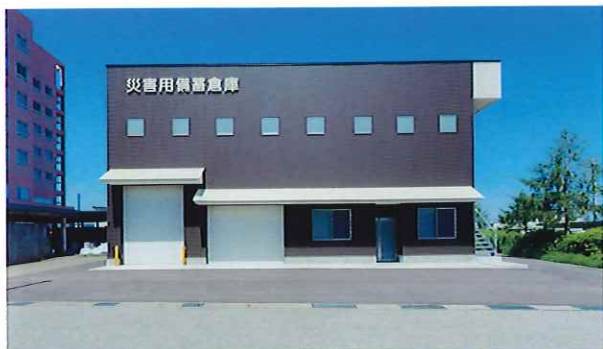
新設された「災害用備蓄倉庫」の外観
