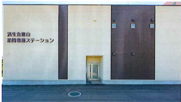
完成した「済生会富山訪問看護ステーション」の外観
